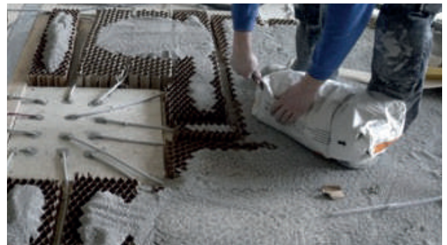
Bodenschüttung zur Schalldämmung.
