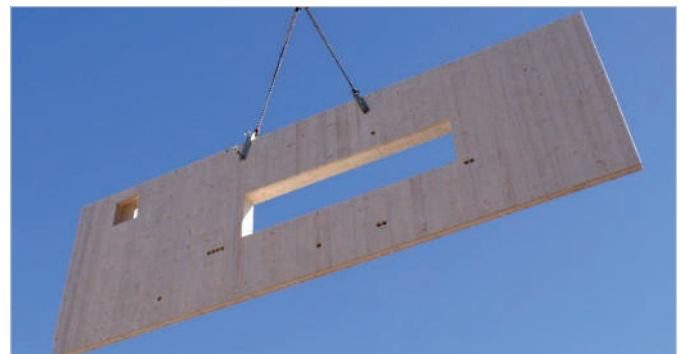
Ein fertiges Wandelement wird mittels Kran eingehoben.
