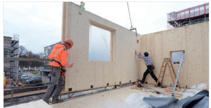
Massive Wände müssen millimetergenau eingebaut werden.
