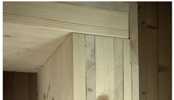
Eine 20,5 cm Wand mit aufliegendem Deckenelement in eingebautem Zustand.
