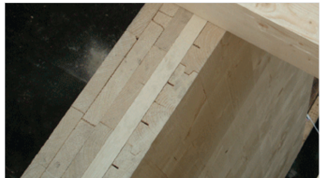
Eine 15,5 cm Wand im eingebauten Zustand.
