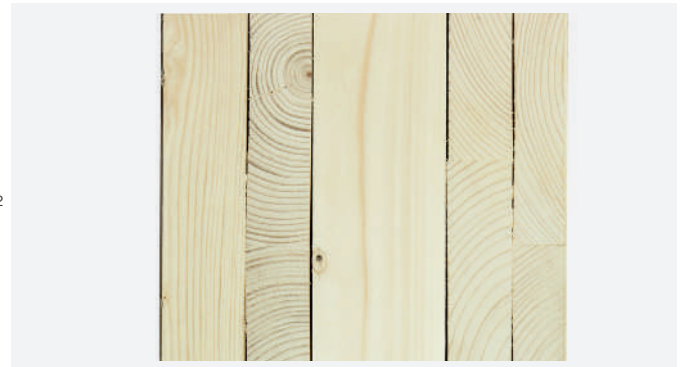
Eine 18,5 cm Wand im Querschnitt.
