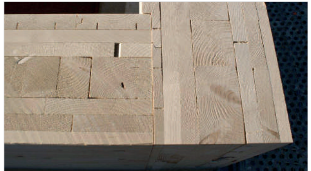
Eine Eckverbindung mittels Ausklinkung.
