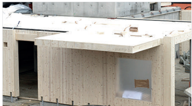
Die Deckenelemente krägen über die Außenwand hinaus und bilden die Plattform für den Balkon.
