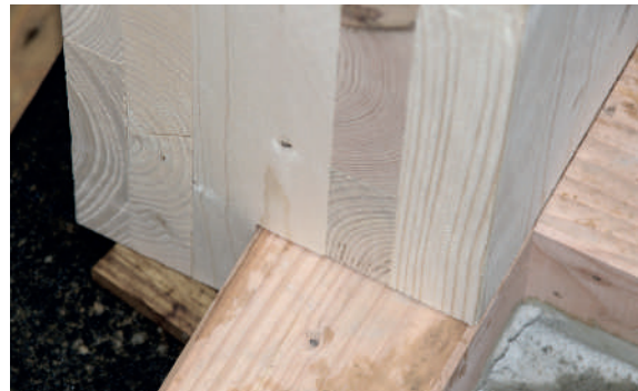
Fertig abgebundene Douglasien-Schwellen.
