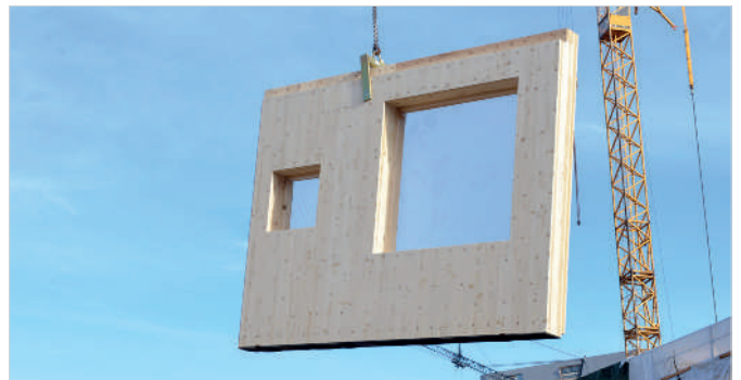
Eine fertig abgebundene 21,5 cm Wand am Kranhaken.
